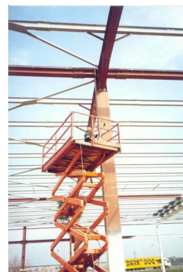
Ειδικές κατασκευές αναμονής από πτώση: δίκτυο προστασίας, στρώματα, κινητοί εξώστες
