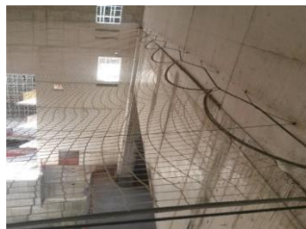
Ειδικές κατασκευές αναμονής από πτώση: δίκτυο προστασίας, στρώματα, κινητοί εξώστες
